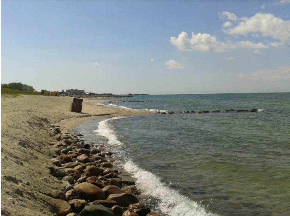
*Abbildung 5: Leeerosion im Bereich des zweiten Bühnenfeldes*
