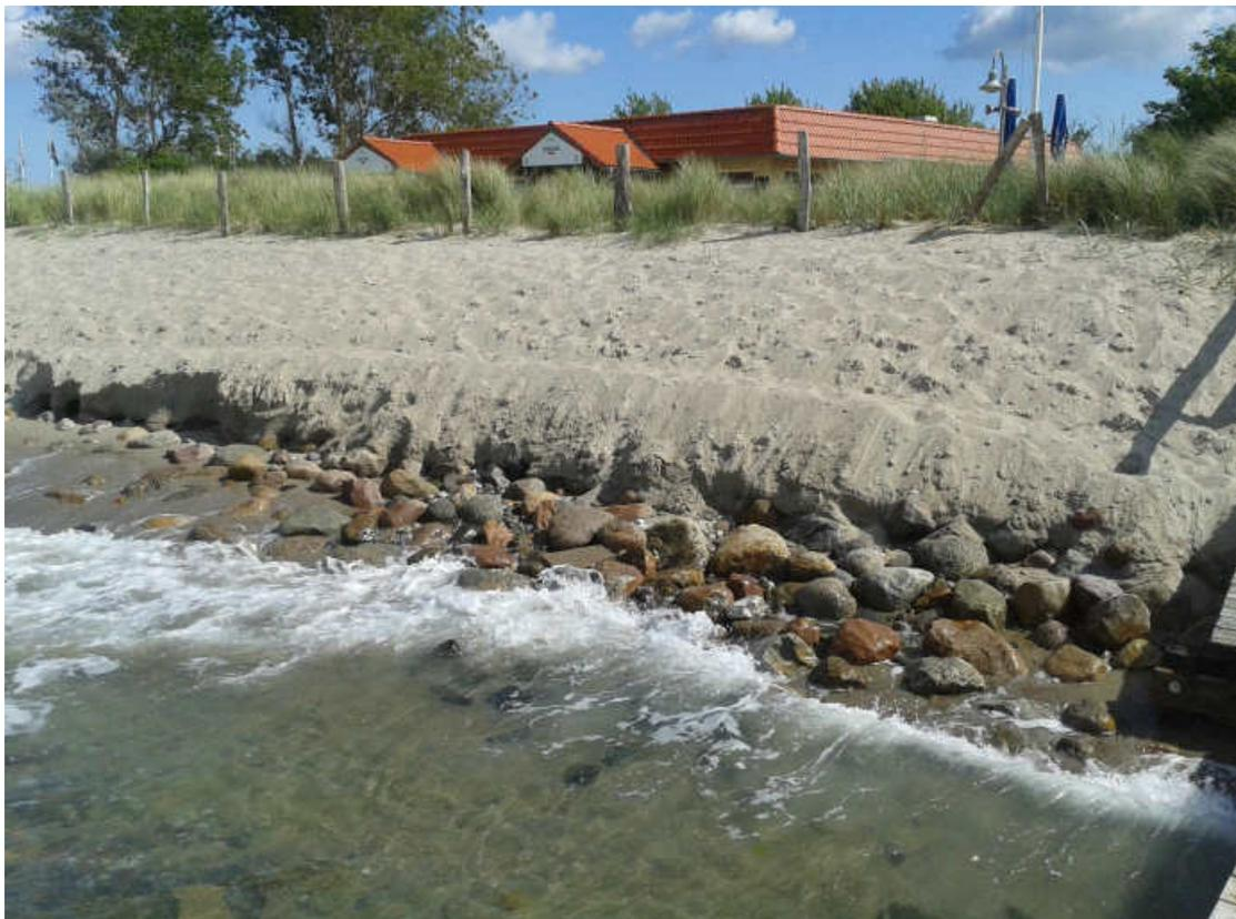
*Abbildung 6: Erosion bis zum Dünenfuß im Bühnenfeld 2*
