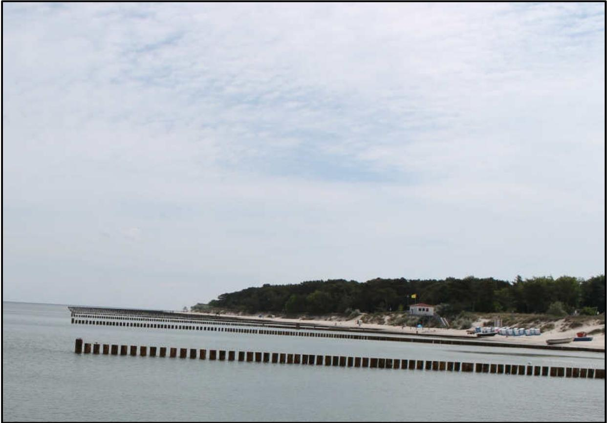
*Abbildung 12: Zunahme der Abstände der Holzpfähle zum Bühnenkopf [Fa. Reuse]*
